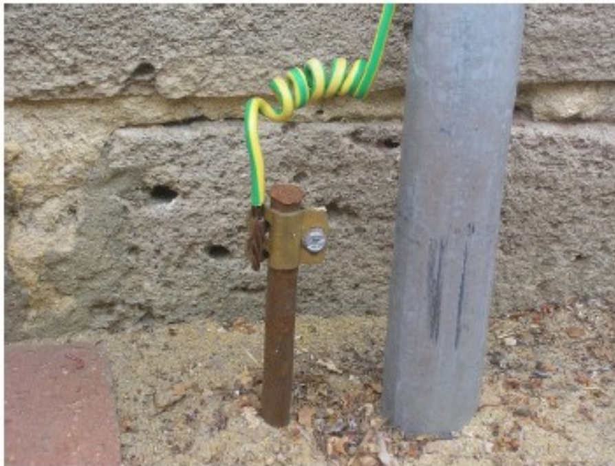
Typische Kupfer-Erdung an Hauswand
